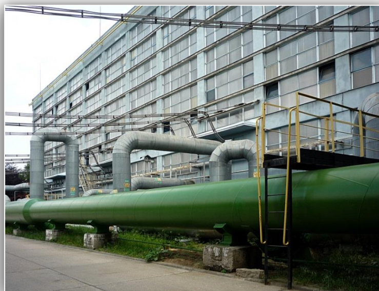
Rurociągi, którymi odprowadza się gorącą wodę do cieci ciepłowniczej Warszawy
