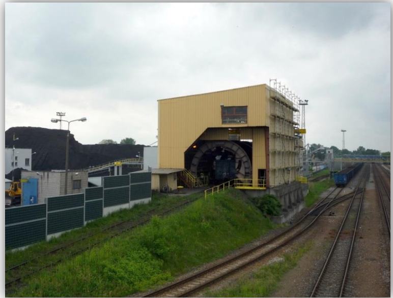
Wywrotnica kolejowa obracająca wagon z węglem
