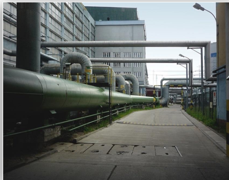
Rurociągi, którymi odprowadza się gorącą wodę do cieci ciepłowniczej Warszawy
