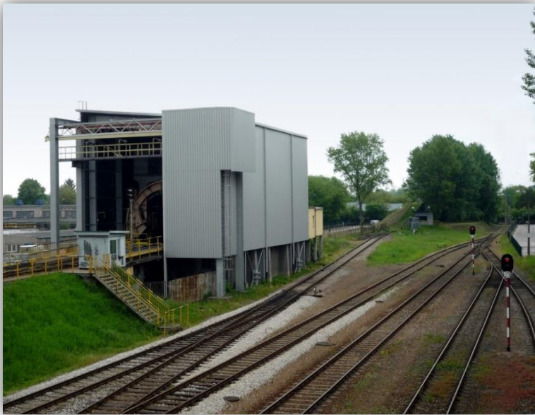
Wywrotnica kolejowa obracająca wagon z węglem
