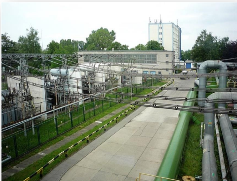
Rurociągi, którymi odprowadza się gorącą wodę do cieci ciepłowniczej Warszawy
